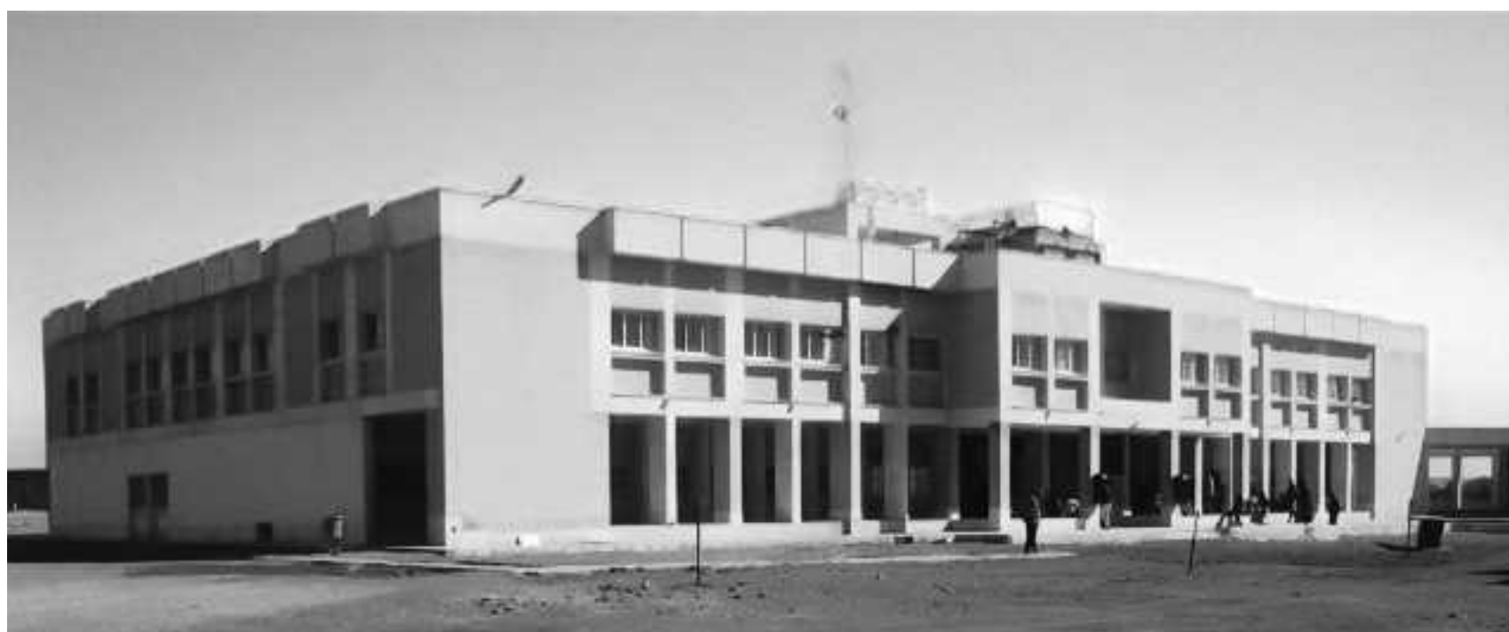
احداث ساختمان های فرماندهی راهور استان اصفهان
